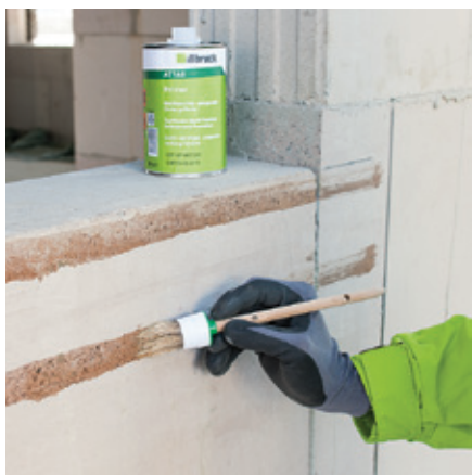
Obr. 4: Příprava zdiva a penetrace
