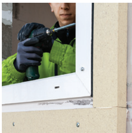
Obr. 8: Upevnění okenního rámu pomocí okenních šroubů. Utěsnění připojovací spáry komprimační páskou TP652 illmodTrio+
