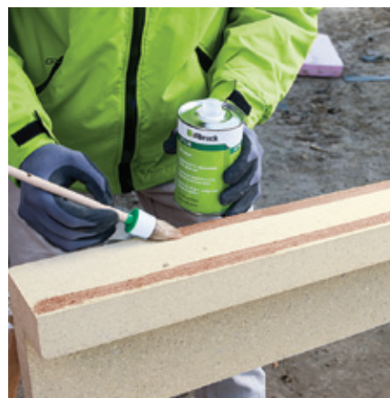
Obr. 3: Příprava lepených ploch podkladním nátěrem podkladním nátěrem illbruck AT140
