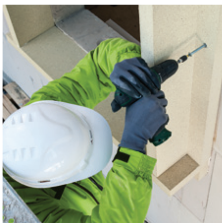
Obr. 7: Zajištění všech ráků pojistnými šrouby
