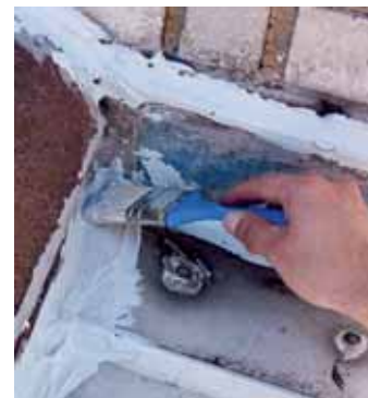
2. Rozetření štětcem. Lze aplikovat i několik vrstev.
