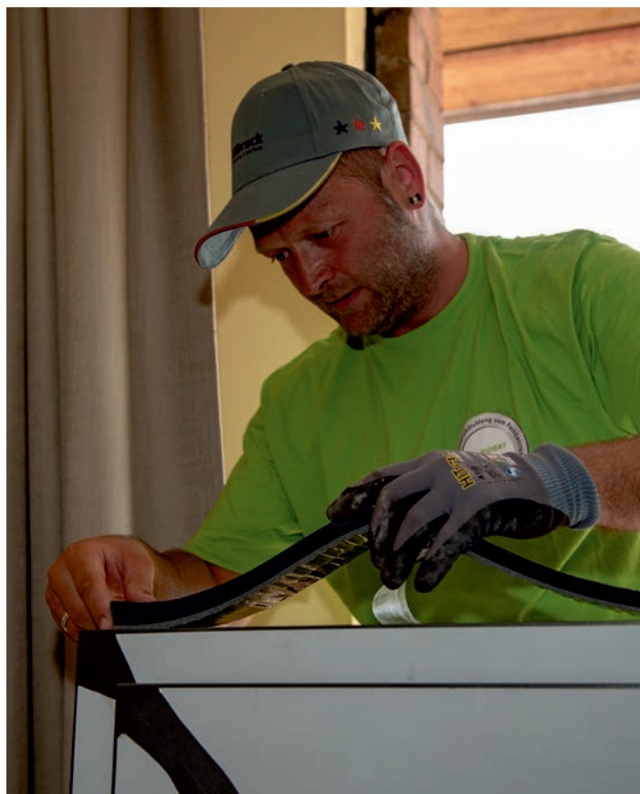
Jednoduchá aplikace komprimační pásky na rám okna
