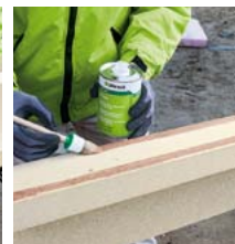
3. Příprava lepených ploch podkladním nátěrem illbruck podkladním nátěrem illbruck AT140.
