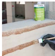
4. Příprava zdiva a penetrace.
