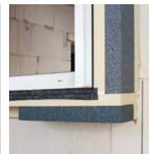
9. Aplikace hydroizolační fólie illbruck proti tlakové vodě a izolačních klínů PR012.
