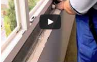
Jak na správnou výměnu oken v panelových domech
